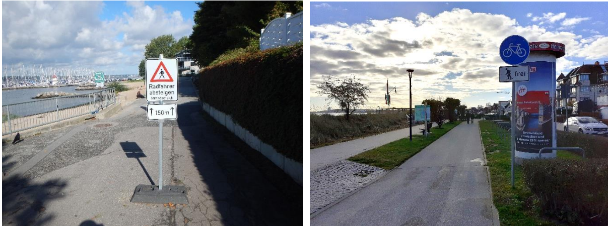
Abbildung 22: Konflikt Fuß- und Radverkehr in Mönkeberg links. Gute bauliche Trennung von Fuß- und Radverkehr in Scharbeutz rechts. Eigene Aufnahmen.
