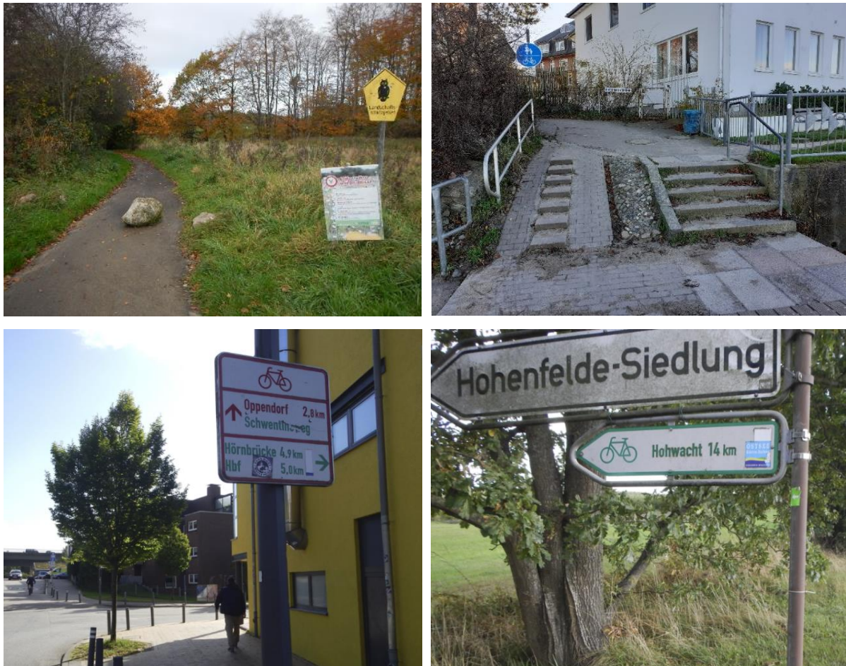
Abbildung 18: Beispiele identifizierter punktueller Mängel des Ostseeküstenradwegs. Links ein mittig im Weg liegender Stein als Unfallgefahr. Rechts eine Treppe mit steiler und schmaler Rampe als erhebliche Barriere mit hoher Unfallgefahr. Unten links Radwegweiser in Kiel mit verblichemem Aufkleber vom Ostseeküstenradweg als Richtungsanzeiger sowie rechts ein veralteter Zielwegweiser im Kreis Plön Eigene Aufnahmen.
