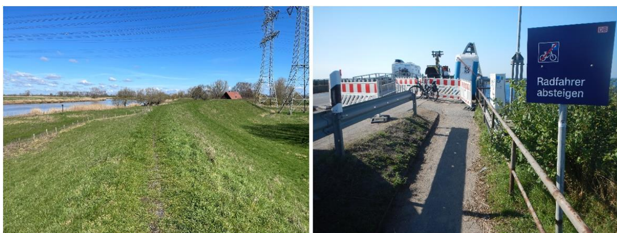
Abbildung 26: Beispiele identifizierter Mängelstrecken auf dem Mönchsweg. Links ein unbefahrbarer Weg auf einer Deichkrone an der Stör. Rechts der zu schmale Geh- und Radweg auf der Fehmarnsundbrücke. Eigene Aufnahmen.
