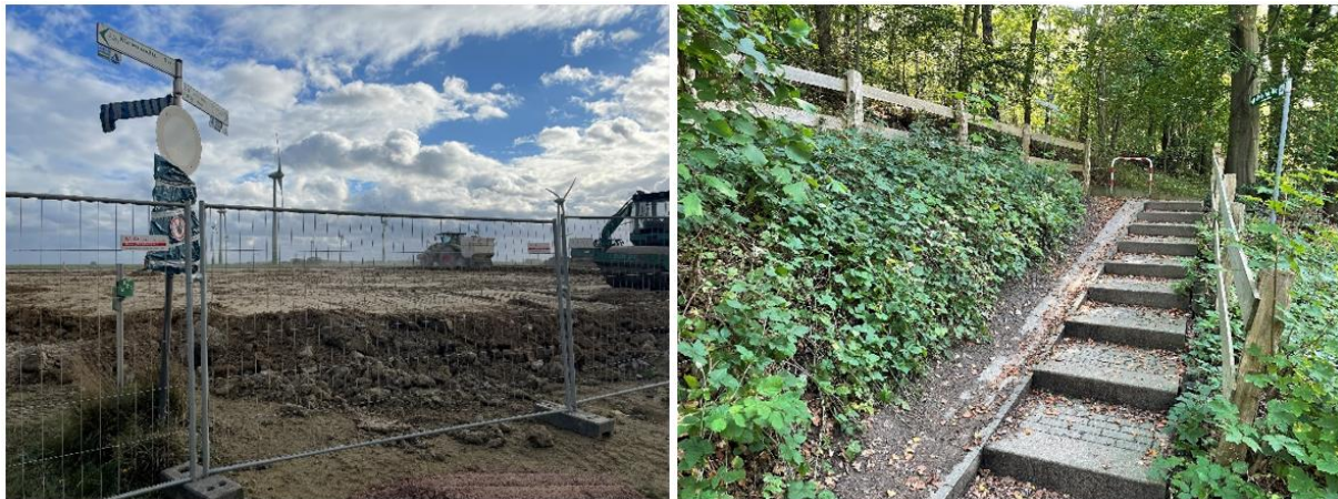
Abbildung 28: Beispiele identifizierter punktueller Mängel des Mönchswegs. Links ein auf die Baustelle des Fehmarnbelt-Tunnels zeigender Armwegweiser (Wegweisungsmangel). Rechts eine Treppe mit zu schmaler Rampe und Umlaufschranke bei Bosau. Eigene Aufnahmen.
