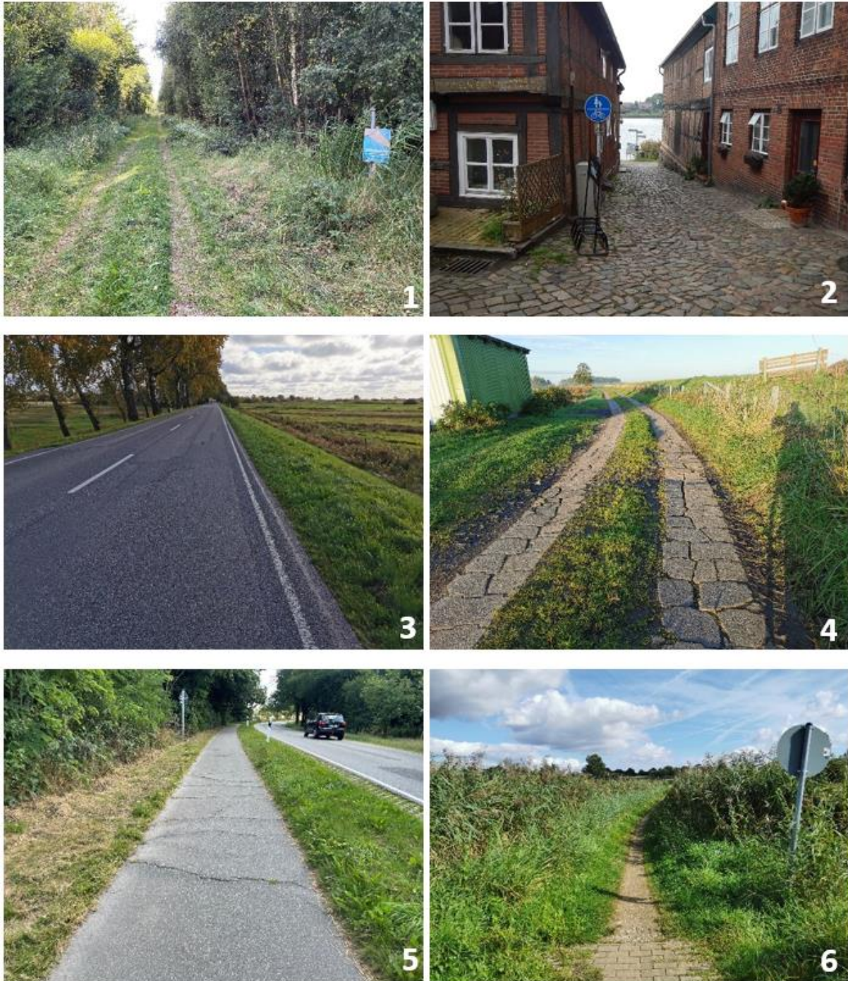
Abbildung 16: Bildercollage von Negativbeispielen der im Rahmen der Befahrung aufgenommenen Abschnitte. Bild 1: Unbefahrbarer Forstweg mit Grasdecke bei Aventoft, Grenzroute. Bild 2: Schlecht befahrbares grobes Kopfsteinpflaster in Lauenburg, Hamburg-Rügen Radweg. Bild 3: Vielbefahrene Landesstraße L 37 ohne Tempolimit und Radweg bei Hollingstedt, Wikinger-Friesen-Weg. Bild 4: Schlecht befahrbare Betonspurbahn auf Grund von schweren Belagsschäden bei Norderstapel, ETS-Radweg. Bild 5: Straßenbegleitender Radweg mit gravierenden Belagsschäden bei Ellund, Grenzroute; Bild 6: Sehr schmaler und schlecht einsehbarer wassergebundener Weg bei Logeberg, Mönchsweg. Eigene Darstellung und Aufnahmen.
