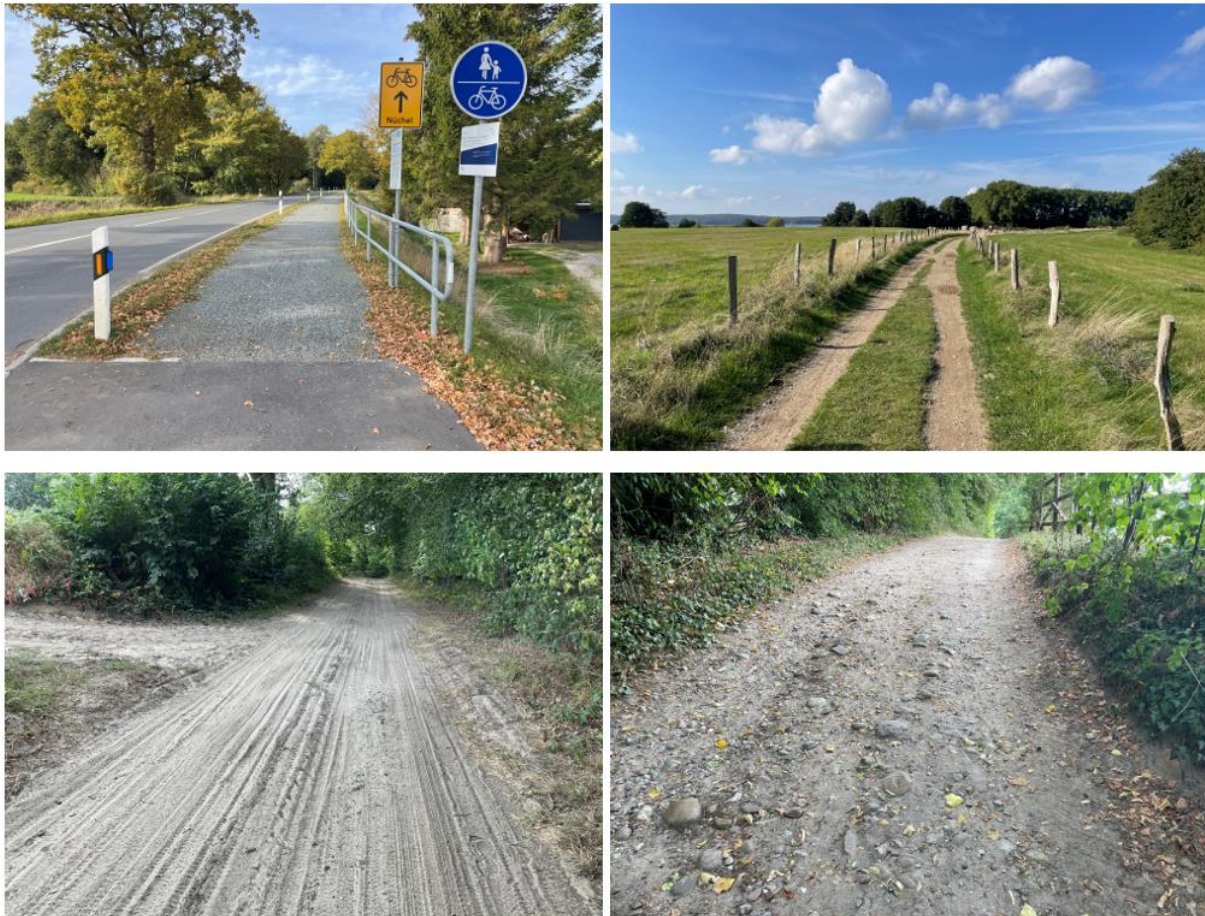
Abbildung 26: Collage von wassergebundenen Wegen der HS-Radtour. Von oben links im Uhrzeigersinn: Straßenbegleitender Radweg mit sehr guter wassergebundener Decke; Feldweg mit starkem Grasbewuchs und schmalen Spurbahnen; Wirtschaftsweg mit sehr sandiger Oberfläche; Privatweg mit großen Steinen im Belag. Eigene Aufnahmen.
