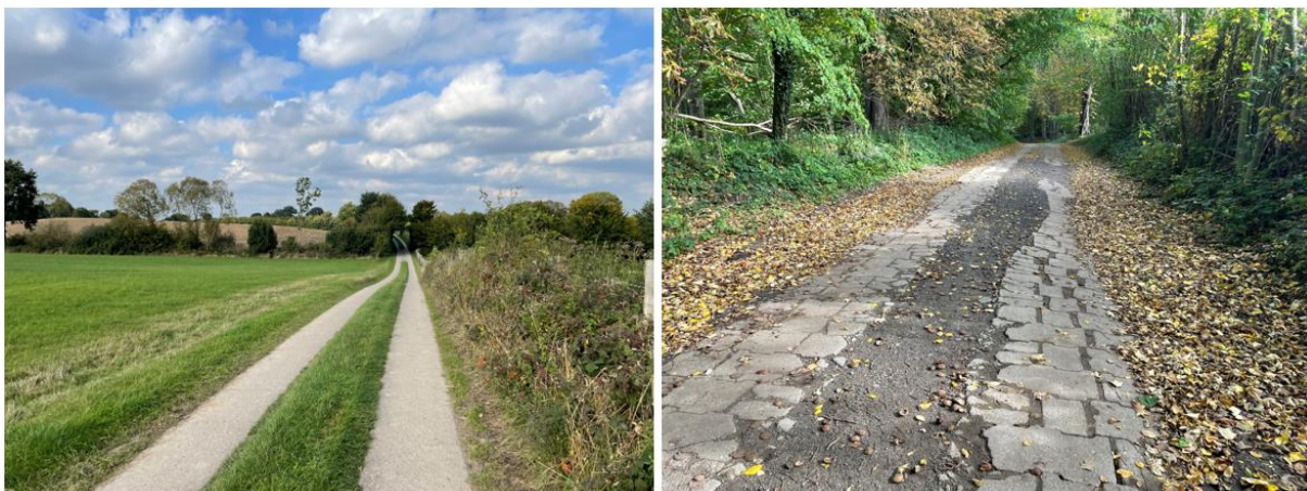
Abbildung 27: Beispiele von Betonspurbahnen der HS-Radtour. Links eine gut befahrbare Betonspurbahn. Rechts eine schlecht befahrbare Betonspurbahn. Eigene Aufnahmen.
