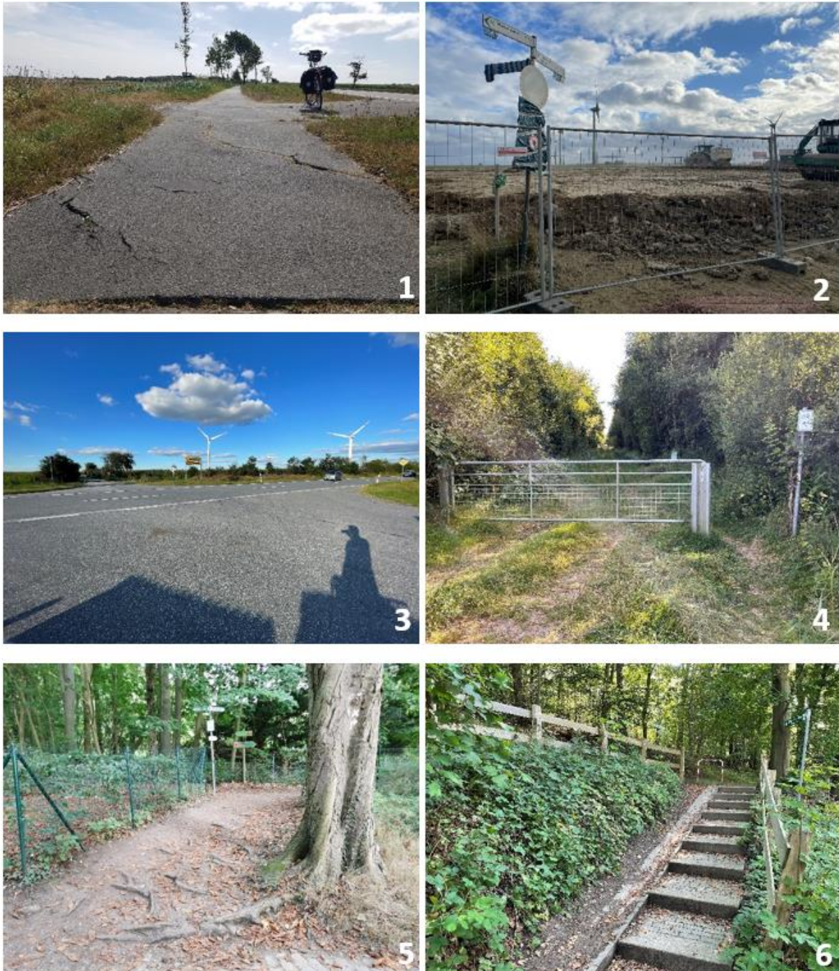
Abbildung 18: Bildercollage von im Rahmen der Befahrung aufgenommenen punktuellen Mängeln. Bild 1: Schwere Belagsschäden auf straßenbegleitendem Radweg bei Welt, Wikinger-Friesen-Weg. Bild 2: Radwegweiser weisen auf abgesperrtes Großbaustellengelände bei Puttgarden, Mönchsweg. Bild 3: Sehr gefährliche ungesicherte Querung der vielbefahrenen L 192 bei Weesby, Grenzroute. Bild 4: Unmarkiertes Gatter mit extrem schmalen Durchgang bei Aventoft, Grenzroute. Bild 5: Ausgeprägte Wurzeln im Weg bei Krummsee, Holsteinische Schweiz Radtour. Bild 6: Treppe mit sehr schmaler Rampe für Radfahrende und Umlaufschranke bei Bosau, Mönchsweg. Eigene Darstellung und Aufnahmen.
