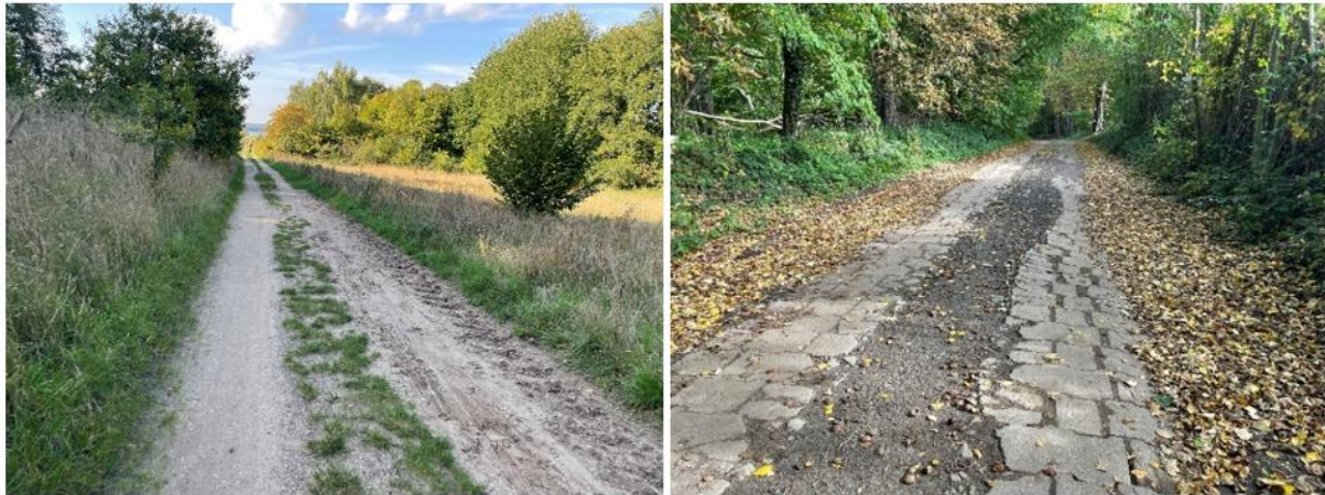
Abbildung 29: Beispiele identifizierter Mängelstrecken an der Holsteinischen Schweiz Radtour. Links ein schlecht befahrbarer, teils sandiger Weg am Plöner See mit schmalen Spurbahnen. Rechts ein Abschnitt mit einer sehr schlechten Betonspurbahn. Eigene Aufnahmen.
