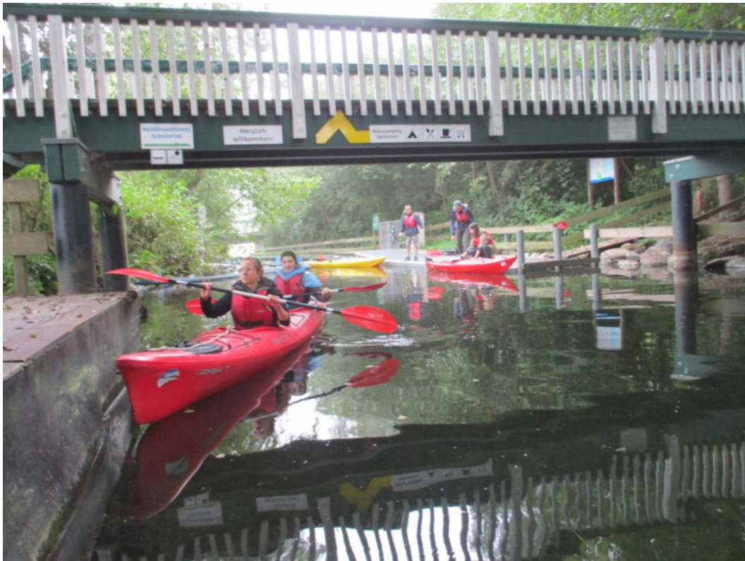
Abb. 32. Qualitätskriterium Steghöhe über der Wasserfläche: Alter, zu hoher Steg im Vordergrund, neuer kanugerechter Steg im Hintergrund
